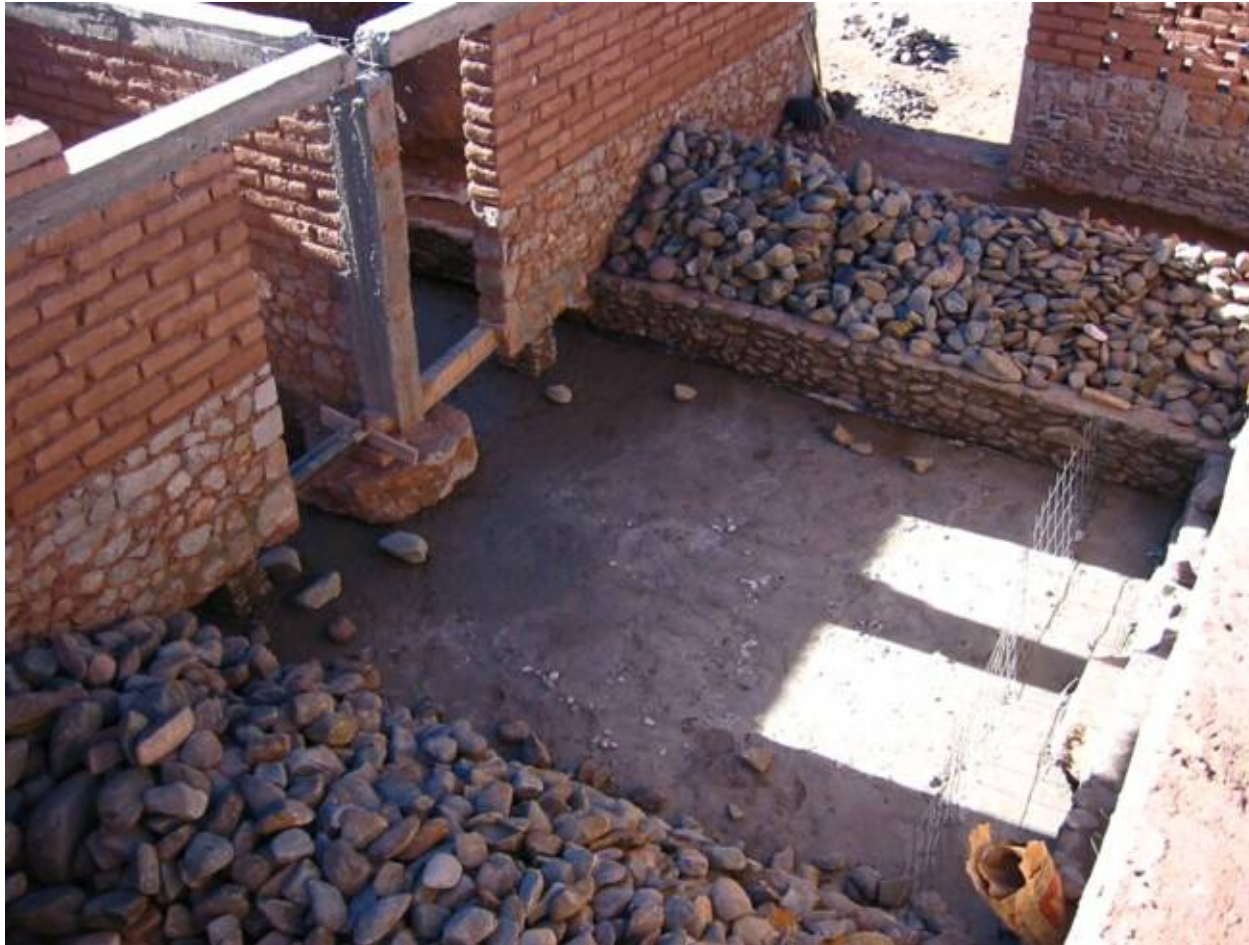
Solarer Fußbodenheizung
