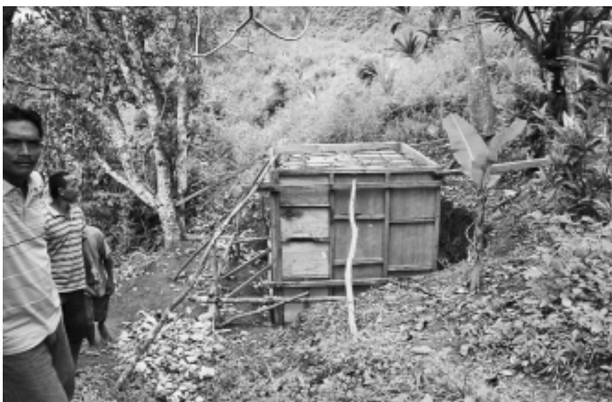
Wasserreservoir auf Catmon (Philippinen)
