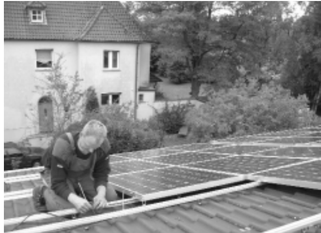
Auf dem Dach des Gemeindehauses Friedenskirche wird eine 8,6 kWp-Photovoltaik-Anlage montiert.
